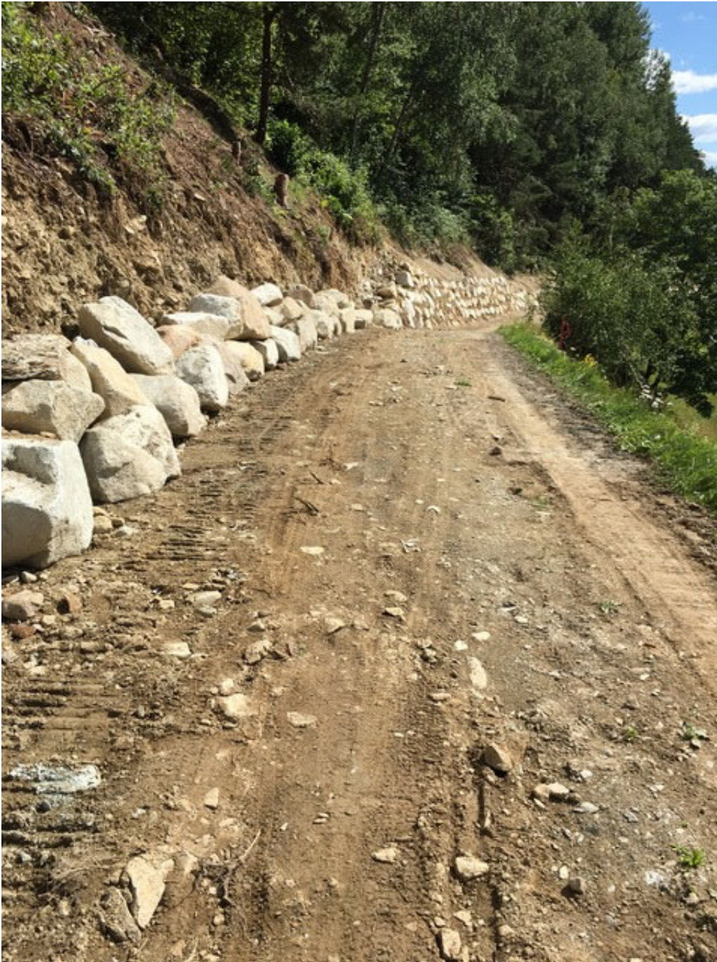
Statt alter Weg, Strasse für den Traktor, statt Trocken-, Zyklopenmauer.
