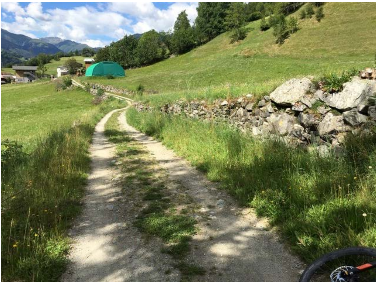
Baustopp: Der uralte Saumpfad bei Disla soll nicht einer Strasse weichen. Fotos: Leo Tuor
